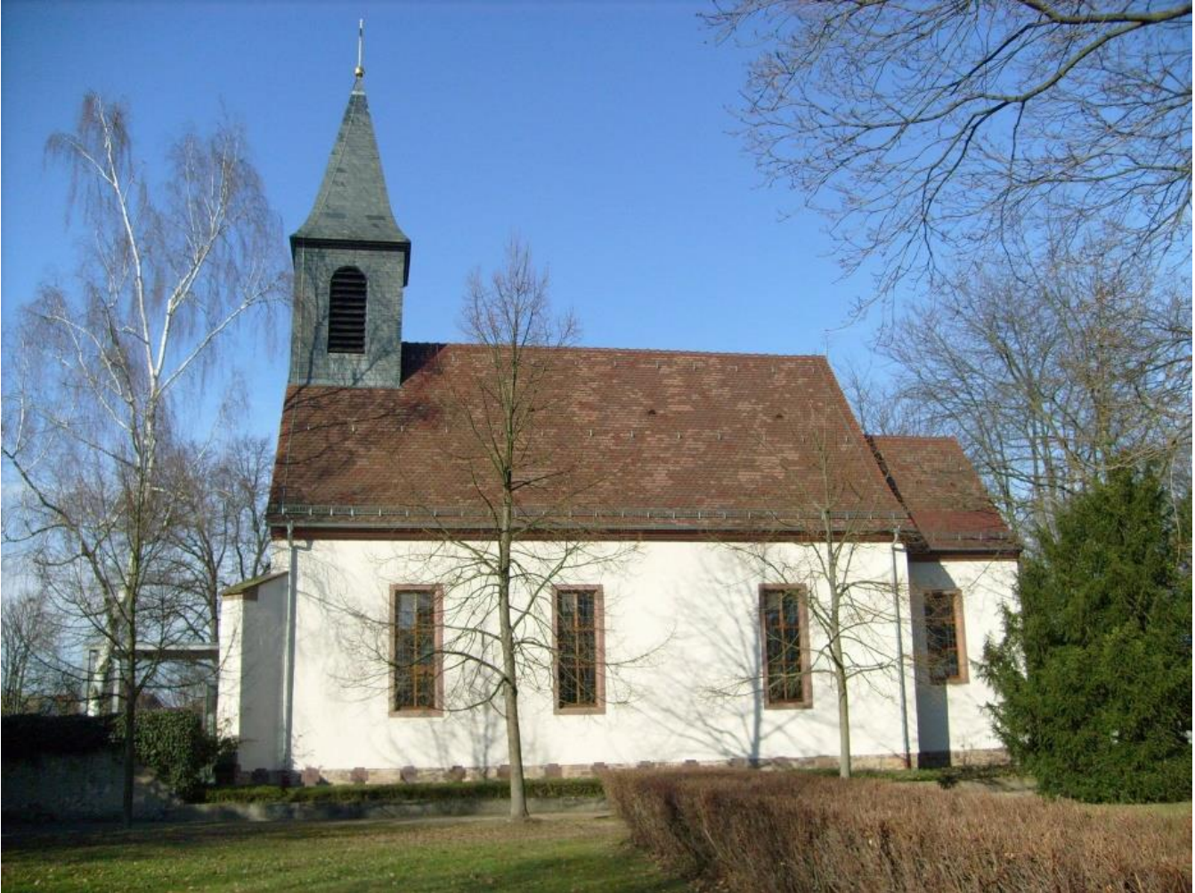
Die Laurentiuskirche (Südseite)
